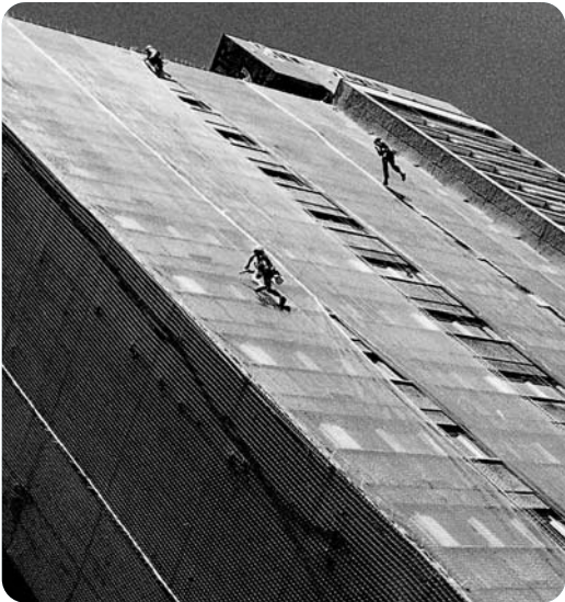
Komplette Gebäudevernetzung, Berlin Foto: Archiv NAWROCKI ALPIN
